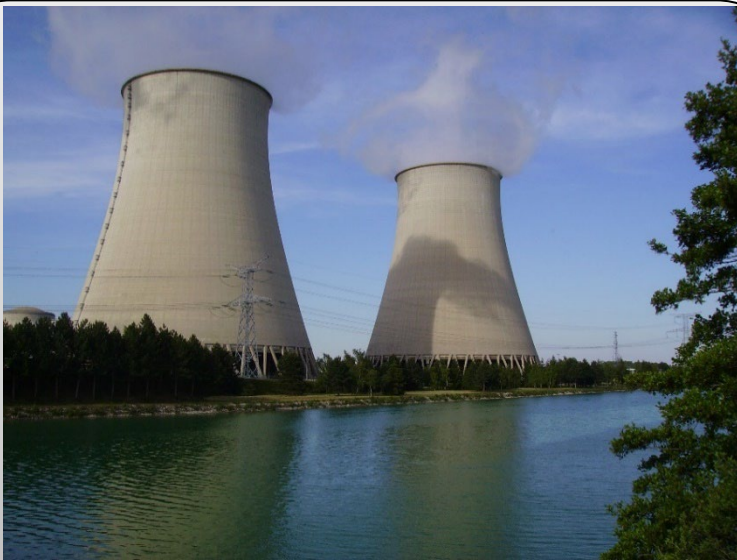
Centrale nucléaire de Nogent
