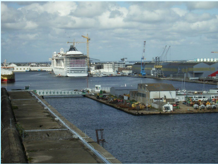
Les chantiers navals de St Nazaire
